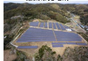
館山市発電所
